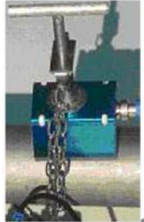
Figura 6: Fixação dos Transdutores
